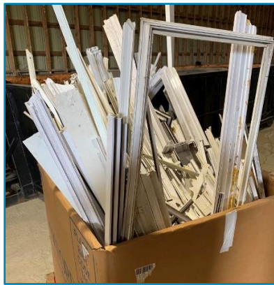
Figure 37 PVC récupéré lors du démantèlement
